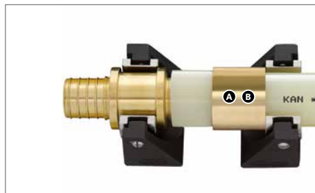
Монтаж двухстороннего соединителя Ø25×3,5
