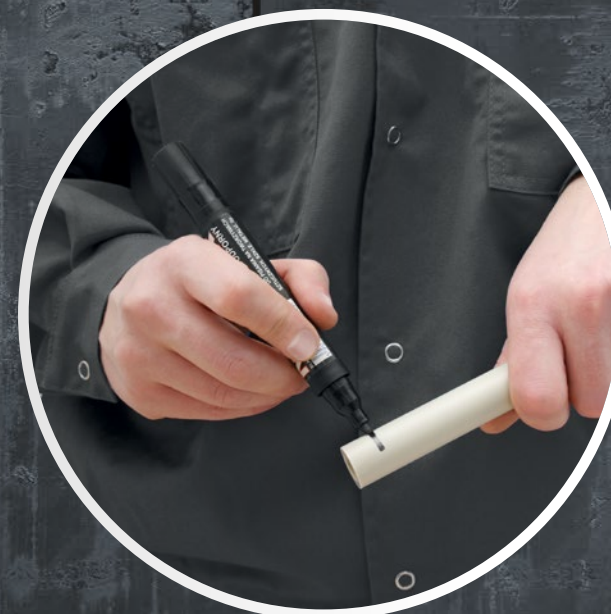
03 Zaznaczanie głębokości zgrzewania.
